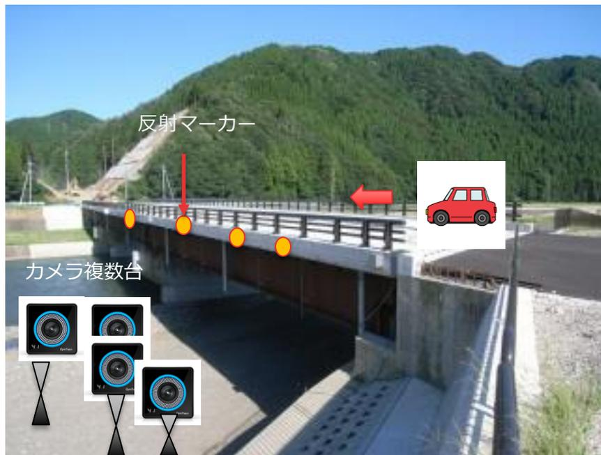
車が通った際の沈下量が0.1mm単位で解析・モニタリング可能
